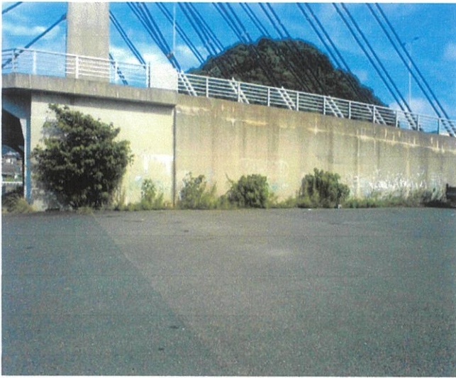
門司区新門司大橋 橋台
