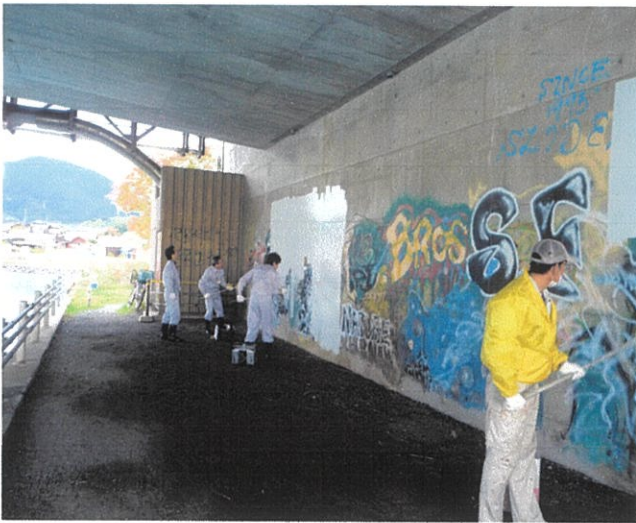
門司区新門司大橋 橋台
